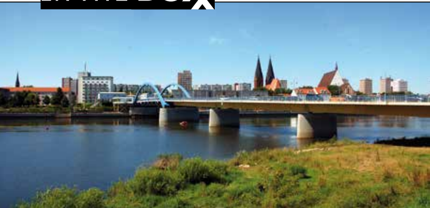
Die Stadtbrücke über die Oder verbindet Frankfurt und Stubiце
