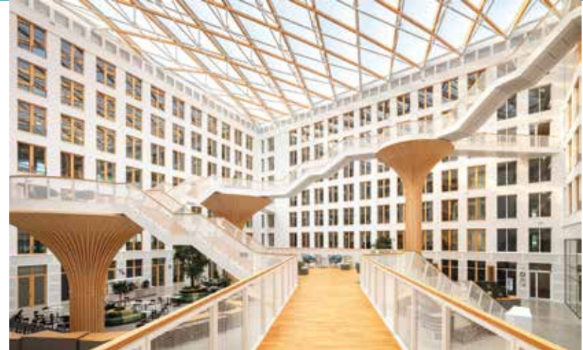
Ganz im Sinne der Nachhaltigkeit: das EDGE Südkreuz Berlin wurde in Holz-Hybrid-Bauweise errichtet
